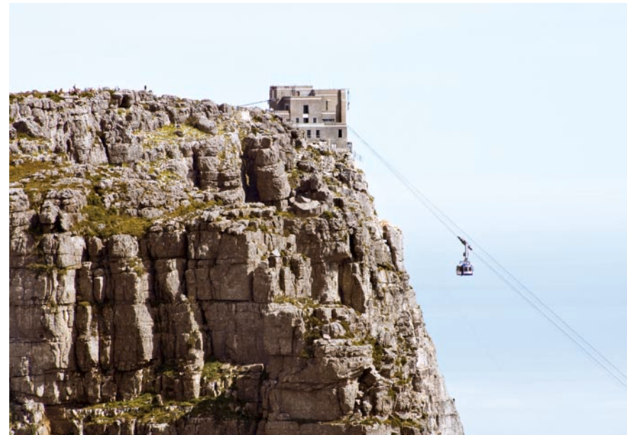
Upper Cable Station auf dem Tafelberg.
