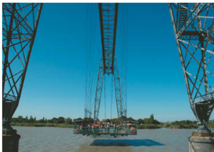
En route pour la rive sud, la plateforme mobile du dernier pont transbordeur de France, à Rochefort.
