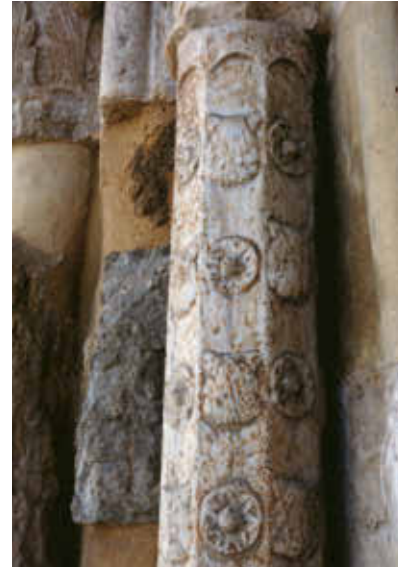
EGLISE DE SÃO TIAGO (SAINT-JACQUES) , romane du dernier quart du XII e siècle. Colonnes ornées de coquilles Saint-Jacques.
